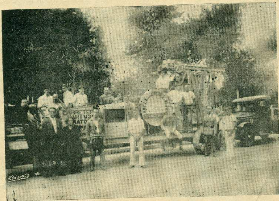
Aparecen en la fotografía la distinguida dama doña Adela Gargollo Vda. de Jiménez, sus hijos don Guillermo y don Oscar Jiménez Gargollo y un grupo de operarios. Este quebrador está calculado para triturar 100 metros cúbicos de piedra cada diez horas.
